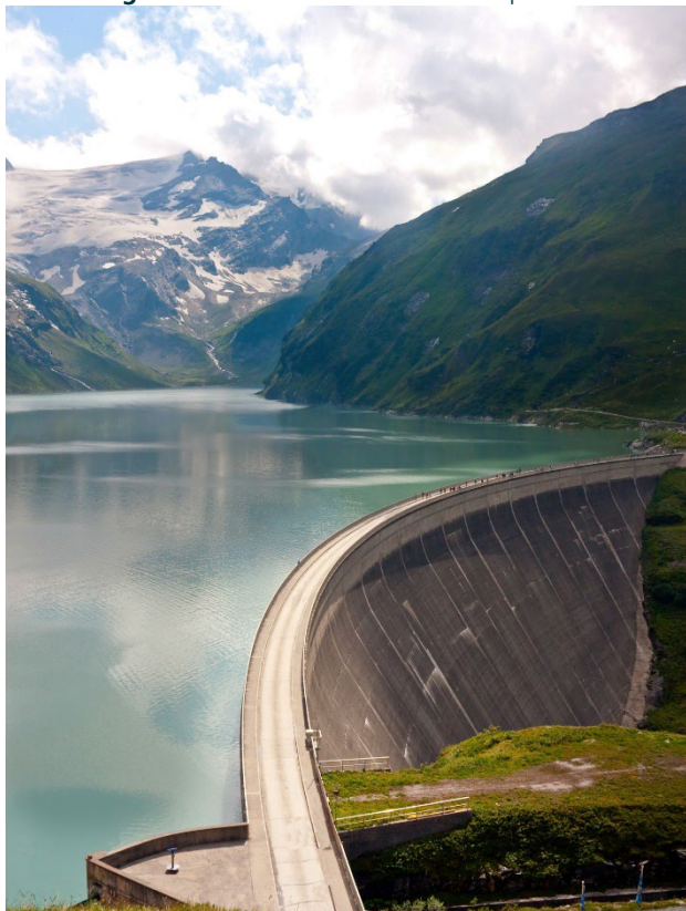
Abbildung 3: Staumauer des Kraftwerks Kaprun
